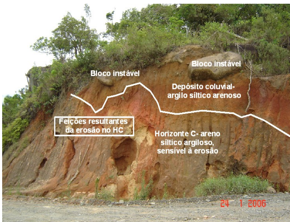
Figura 1.6 - Talude na estrada existente entre Zimbro e Porto Belo, mostrando um depósito coluvial argilo siltico arenoso, avermelhado, assentado sobre o horizonte C da rocha granito-gnáissica. Observa-se a ocorrência de blocos no depósito coluvial, instáveis e a sensibilidade à erosão provocada pela água no solo areno siltico argiloso, correspondente ao horizonte C
